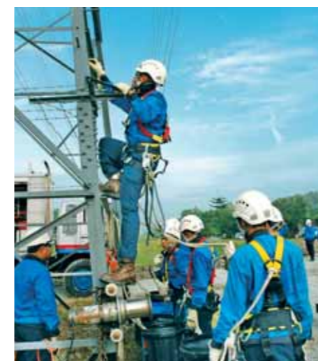
Juruteknik Tenaga Nasional menjalankan kerja-kerja penyelenggaraan di menara penghantaran kuasa
