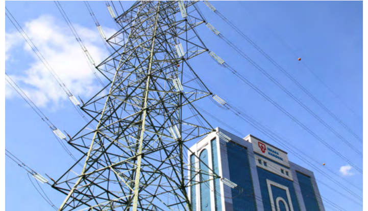
► Menara penghantaran bekalan elektrik Tenaga Nasional Berhad
